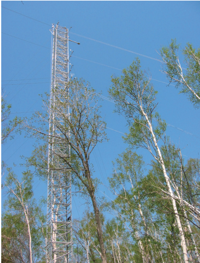
図1 森林に設置された観測タワー
