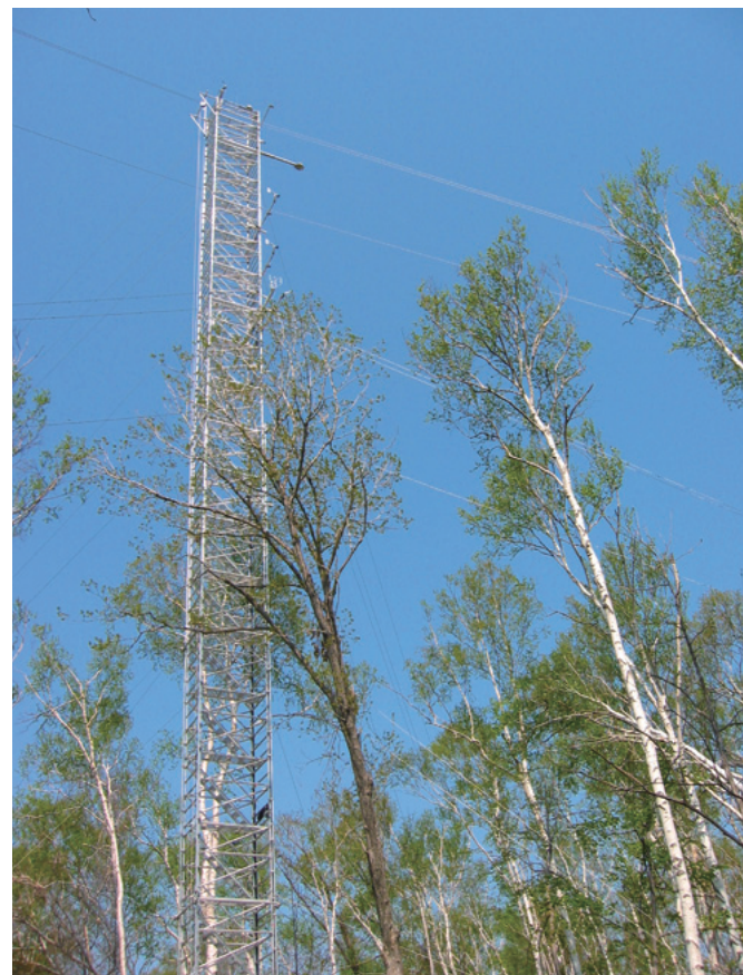
図1 森林に設置された観測タワー
