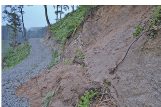
写真2 切取のみ実施した箇所
