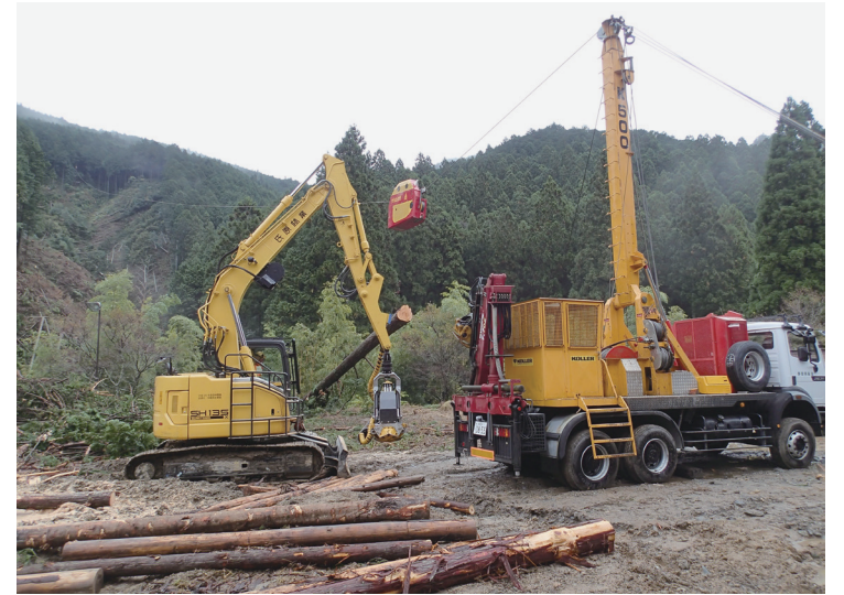
急傾斜地でのタワーヤードを使った搬出作業の効率化
