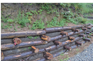
写真3 山側丸太組工施工箇所（吸出防止材を併用）
