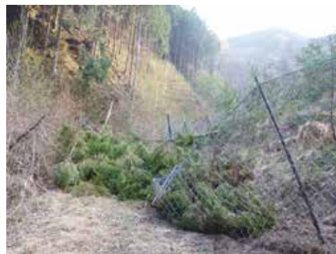
写真2 落枝等による破損
