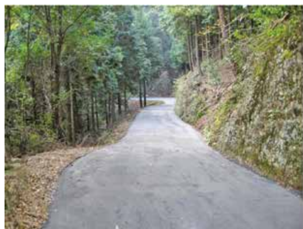
工事完了直後
