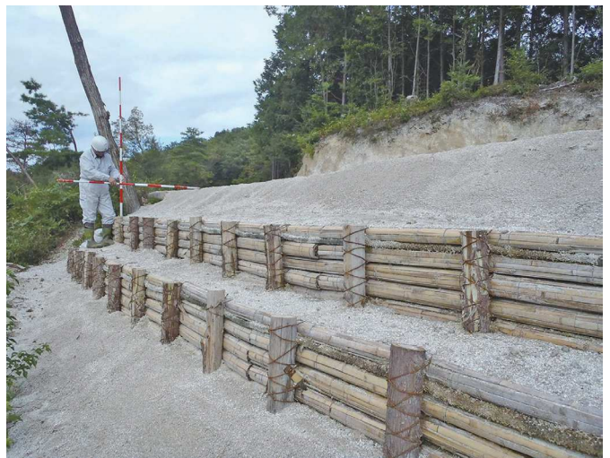
写真3 竹製土留工設置
