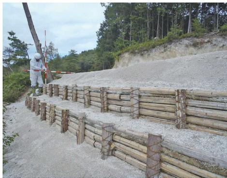
写真3 竹製土留工設置
