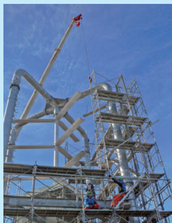
写真5 風力発電機のブレード（風を受ける羽根）を取り付ける作業（2016年1月23日）
