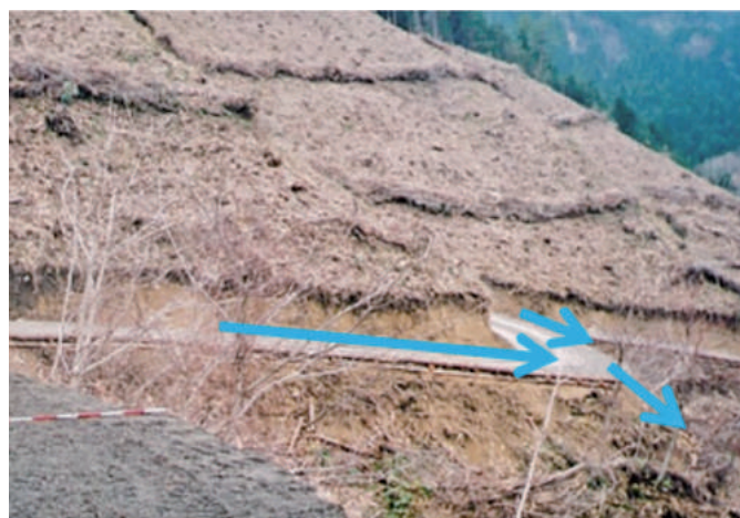
写真1 縦断勾配を利用し、尾根筋等の地質が安定した箇所へ水を誘導
