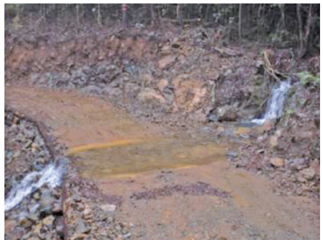
写真2 洗い越し 路面を凹ませて路面の上で水が浅く流れるように施工
