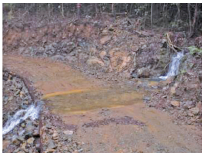
写真2 洗い越し 路面を凹ませて路面の上の水が浅く流れるように施工
