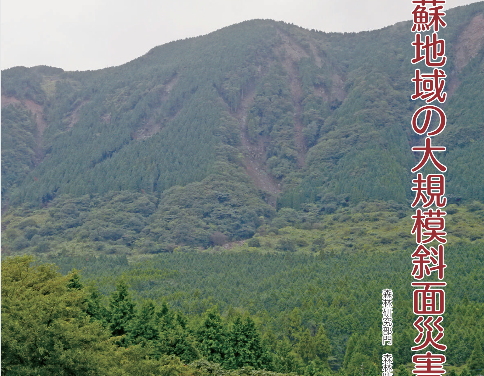
写真1 阿蘇カルデラ外輪山内壁斜面で発生した崩壊群
