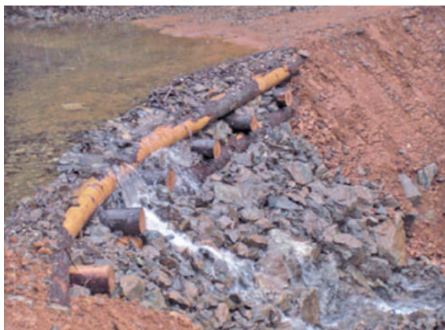
写真3 川側の洗掘防止対策 現地材を利用した丸太組・石積み等を行い、路面と水叩きの落差を極力小さくし、洗掘を防止
