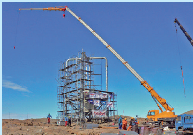
写真4 建設中の風力発電2号機と57次隊が運び込んだ35 t ラフタークレーン（2016年1月24日）
