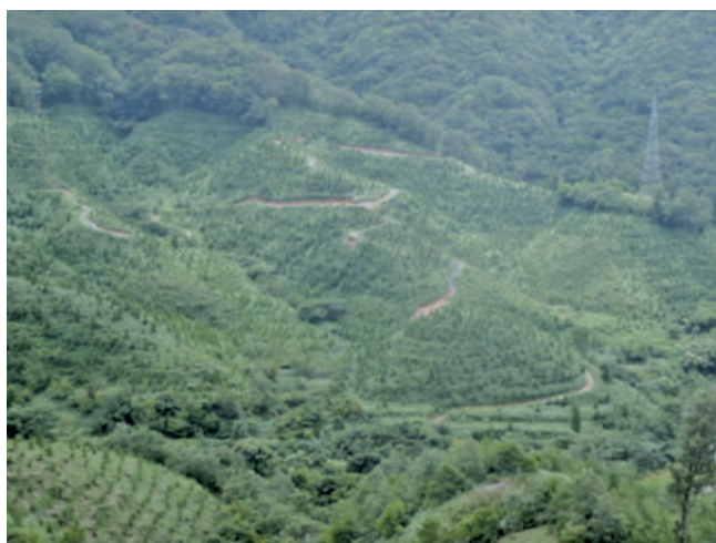
写真4 川戸造林地（島根県江津市）の作業道整備状況
