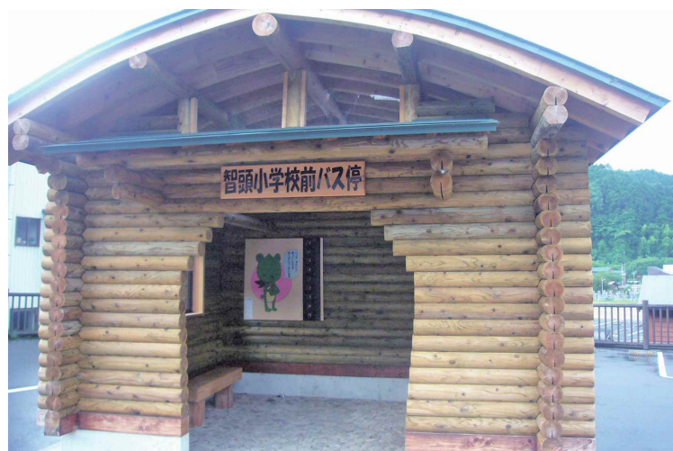
写真2 高等学校森林科学科が間伐材で製作したバス停待合室
