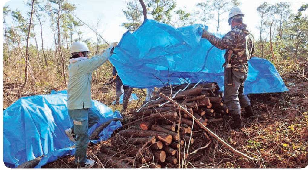
写真3 積み上げた枯れ木をブルーシートで覆う
