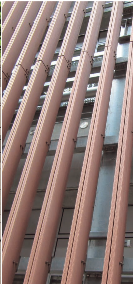
写真1 エクステリアに使用されているWPCの例(左:デッキ、右:ルーバー)
