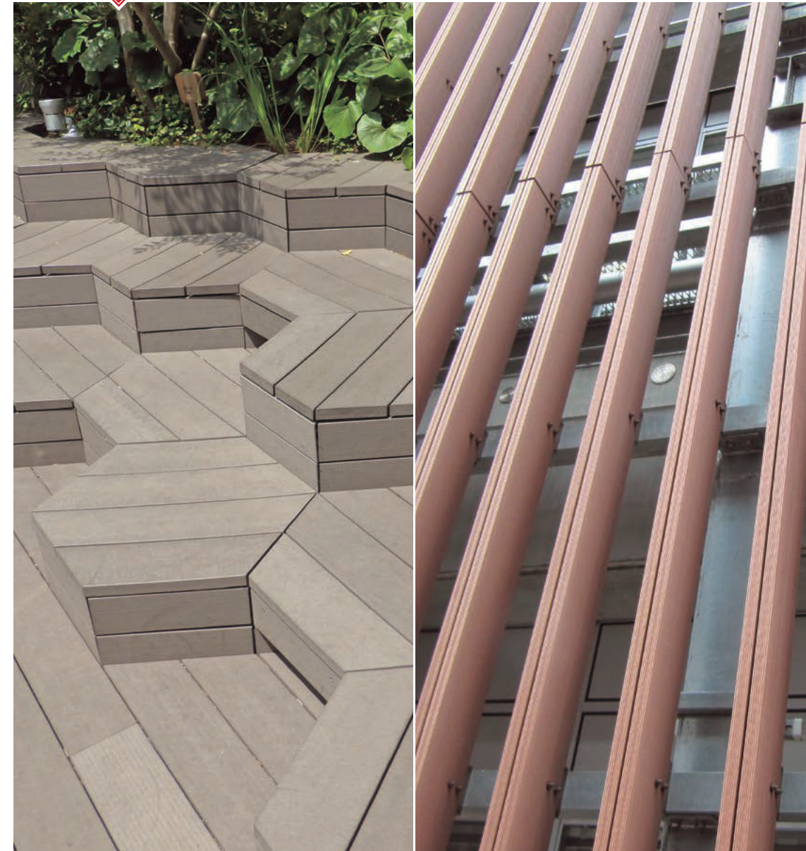
写真1 エクステリアに使用されているWPCの例(左:デッキ、右:ルーバー)
