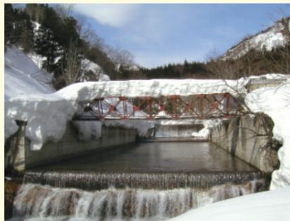
写真2 森林流域から出てくる水の量を測る観測施設(群馬県みなかみ町宝川森林水試験地)
