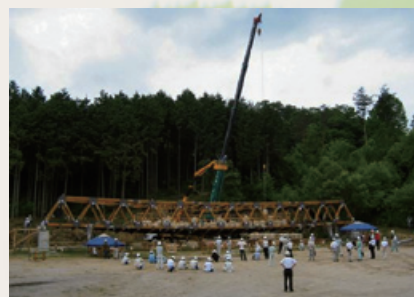
木橋の実大載荷実験風景
