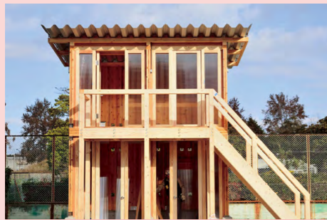
CLTパネル施工方法の開発 CLTを使って施工するためのジョイントの開発など、新工法も研究している。写真は、試験建物（森林総合研究所構内）。
