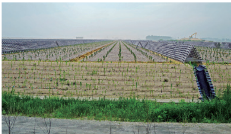
写真2 クロマツが植栽された造成土
