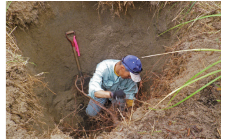
写真1 細い木は人力で掘り上げる 深さ2m以上もスコップで掘った(秋田県向浜)。
