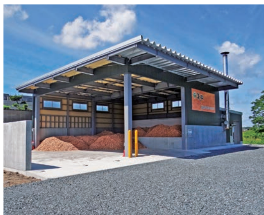
写真2 熱供給施設（チップ燃料サイロとボイラー建屋）
