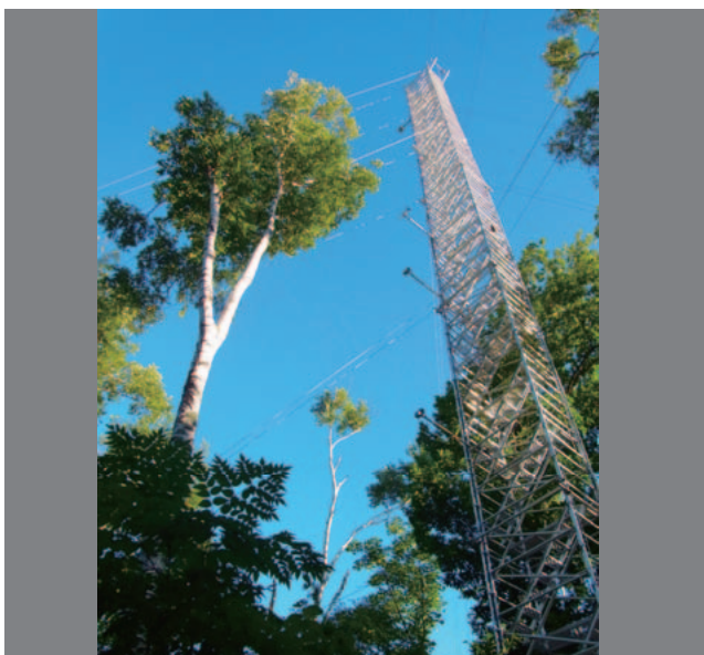
炭酸ガスの吸収・放出などを調べるためのタワー（高さ41m）
