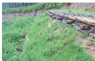
写真5 むしろ張芝工及び浸食防止張芝工施工箇所
