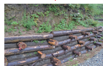
写真3 山側丸太組工施工箇所（吸出防止材を併用）
