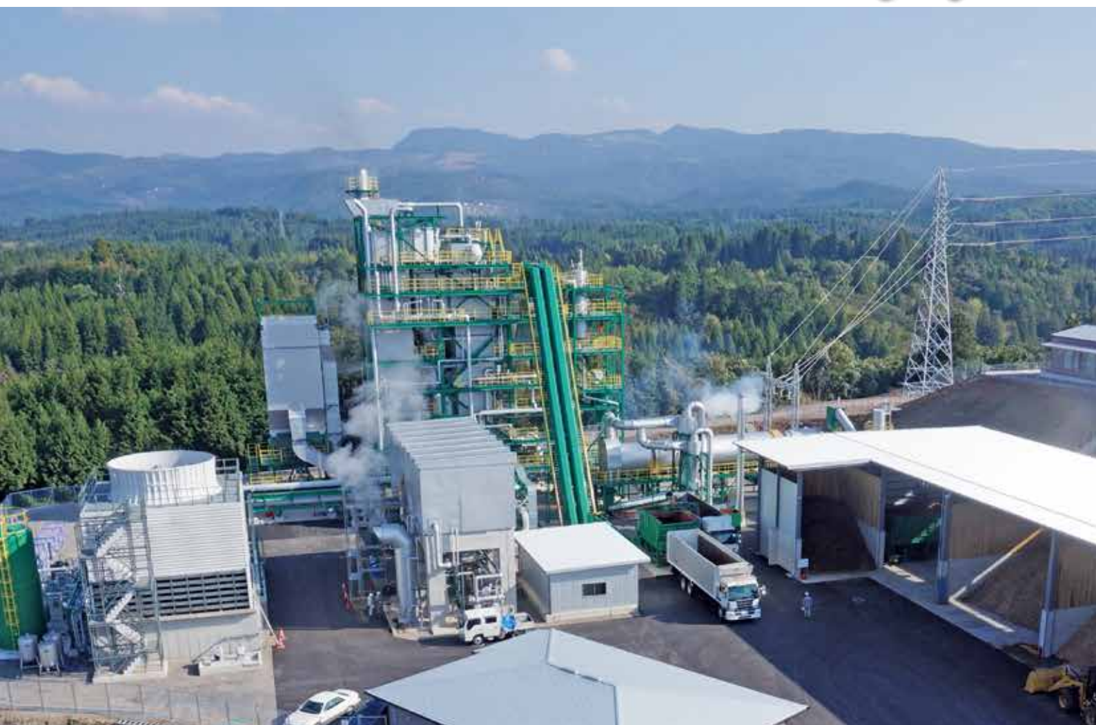
木質バイオマス発電所（大分県日田市）
