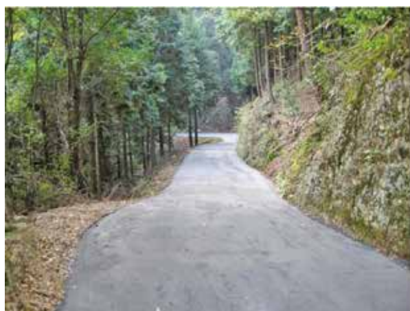
工事完了直後
