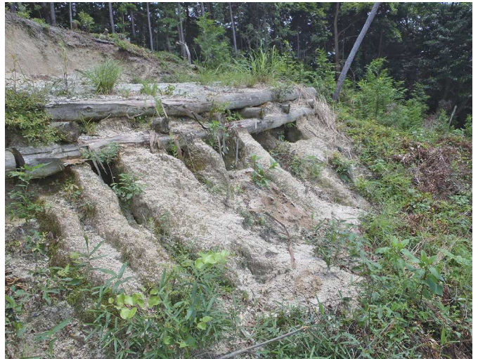
写真1 マサ土地域における法面洗掘
