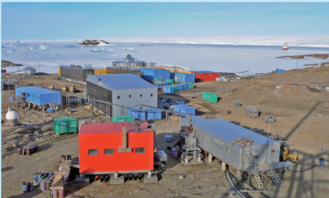
写真3 昭和基地主要部（写真4の足場から撮影）。右遠方に「しらせ」、その向こうに南極大陸が見える。（2016年1月23日）
