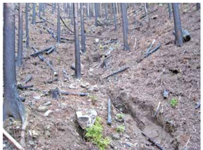
写真4 桐生市の山火事後に発生した林内の土砂流出の様子
