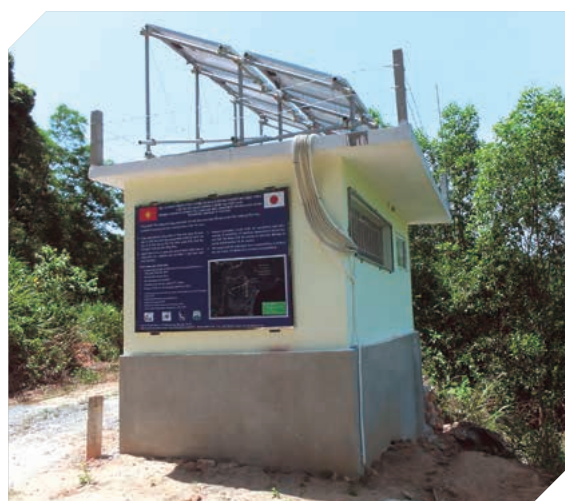
写真4 試験地の対岸斜面に設置した観測基地局
