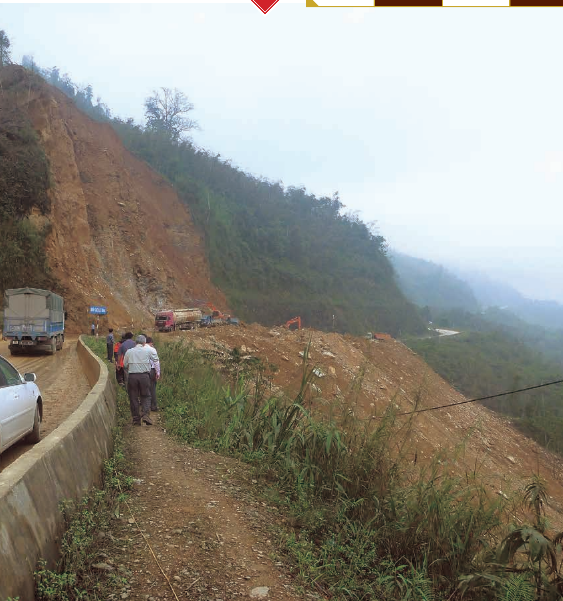
写真1 ベトナムの幹線道路沿いで発生した地すべり
