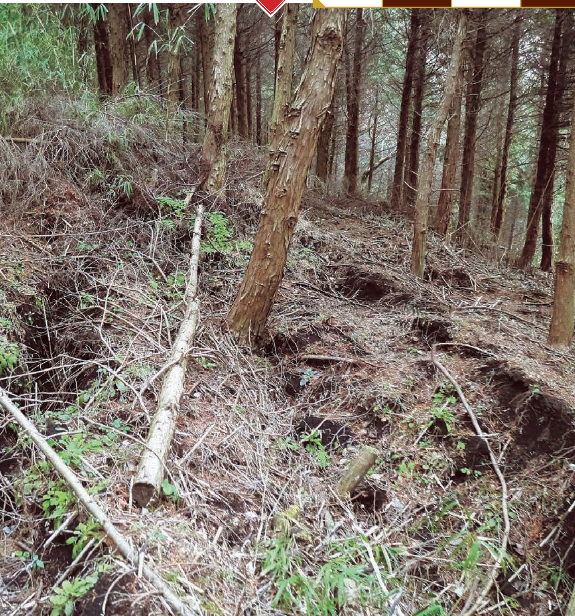
写真1 立野地区の森林内に地震で発生した亀裂
