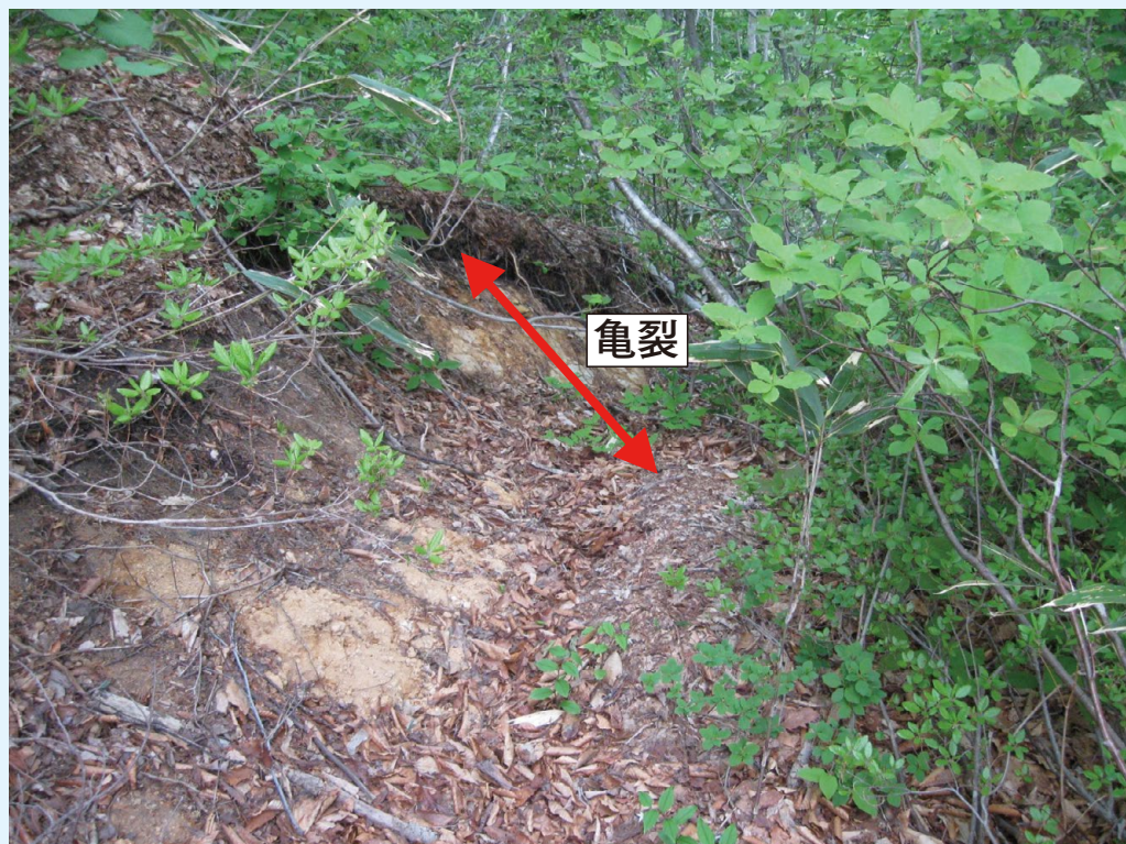
写真2 2008年岩手・宮城内陸地震によって斜面に発生した亀裂
