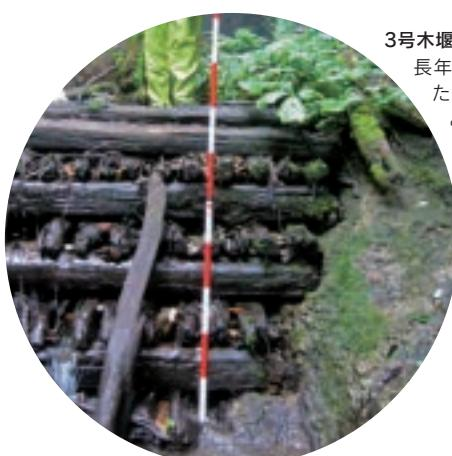
3号木堰堤部材の劣化状況の調査
