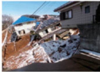
写真 5 斜面崩壊に伴う住宅の転落（福島市）
