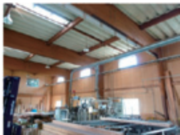
写真 1 3 集成材フレーム部分は無被害の工場
