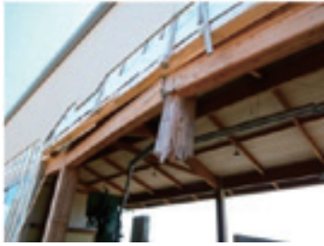
写真 1 9 漂流物の衝突で破壊されたと思われる集成材柱
