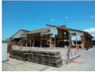
写真 2 0 わん曲集成材アーチ構造の事務所
