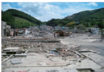
写真 1 0 基礎や土台のみ残った地域（女川町）
