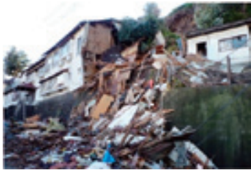
写真 4 斜面崩壊に伴う旅館の倒壊（仙台市）
