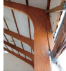
写真 2 1 部分的に破壊が見られるわん曲集成材
