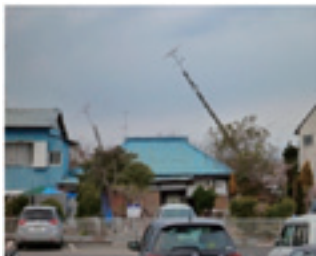
写真 7 液状化による電信柱の傾斜（鉾田市）
