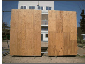
工事用仮囲い（試作品）
