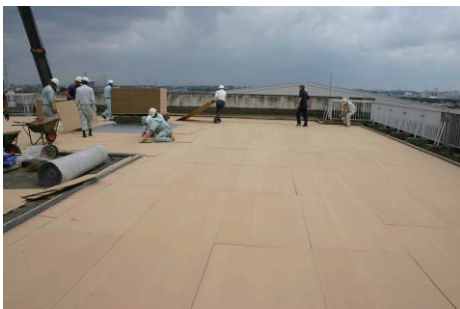
図 10 保水資材を全面に設置
