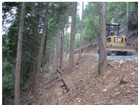
図 3 のり留工による施工例
