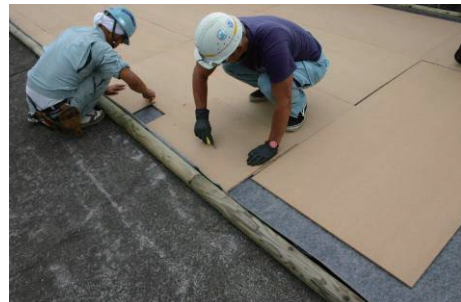
図 9 保水資材の設置 (カッターで簡単に切断可能)
