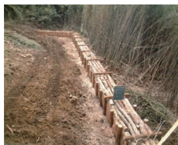
図 1 木製土砂流出防止柵 （安房南部区域（千葉県））
