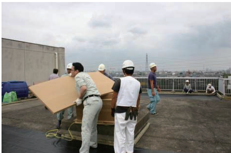
図 8 開発した緑化資材 (軽量であるため設置も簡単)
