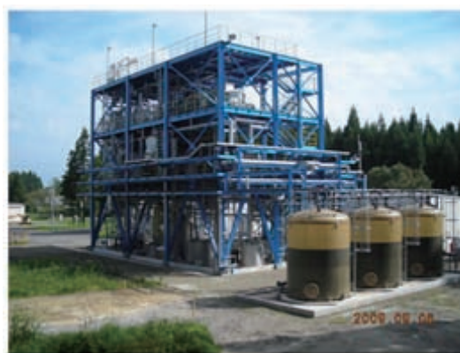
図 10 木質バイオエタノール製造実証プラント
