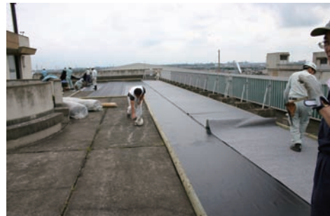
図 7 防水シートおよび根がらみシートの設置
