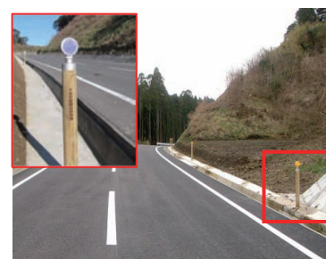
図 3 視線誘導標 (安房南部区域 (千葉県))
