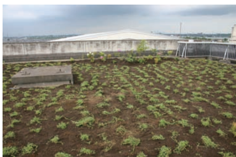
図 12 植え込み終了後の屋上
