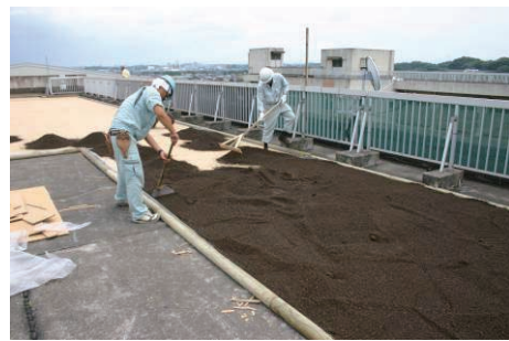
図 11 土壌の設置 (土壌が少ない、簡便な施工)
