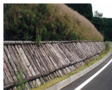
図 2 法面保護工 (阿蘇小国郷区域 (熊本県))
