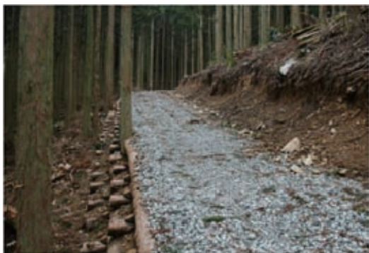
図 2 従来の積上工による施工例
