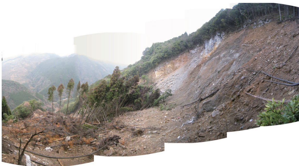
図 2-10 仏像構造線沿い深層崩壊の滑落崖の状況
