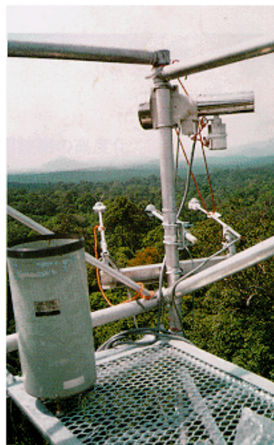
52m高地点における放射量， 気温・湿度，雨量の観測状況
