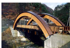
写真1：集成材を用いた橋；愛媛県広田村
