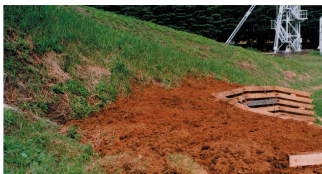
写真1 擁壁の後背部
