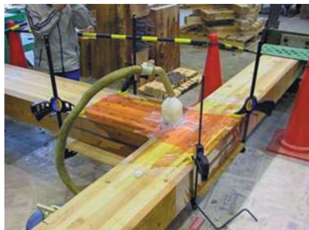
写真1 接着剤充填補修作業の全景
