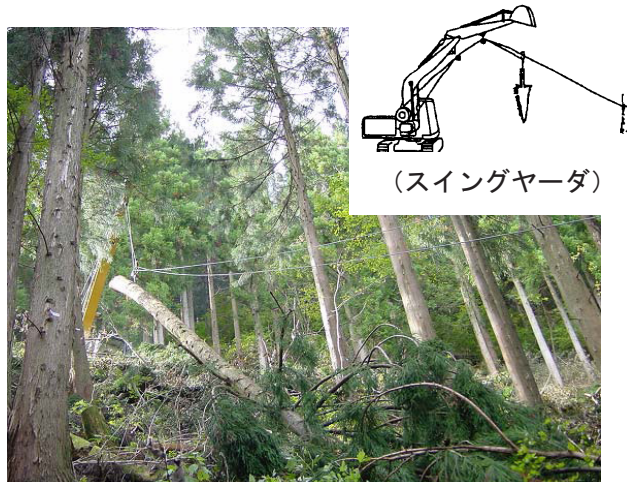
写真2 スイングヤーダによる集材（列状間伐） （枝葉が付いた状態で木材を搬出中。架線の高さがあまり高くありません。）
