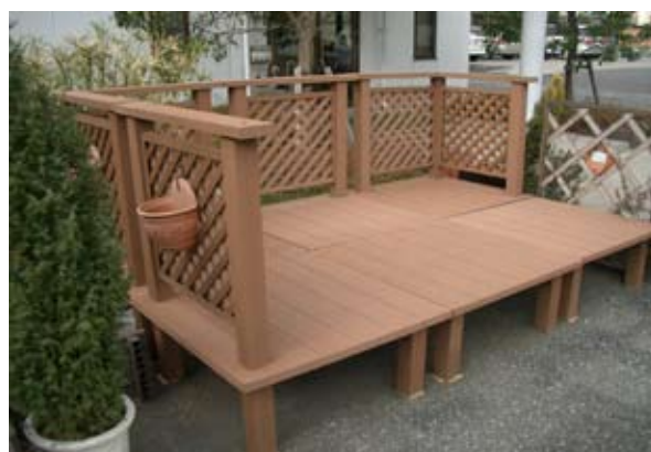
写真2 木材・プラスチック複合材によるデッキ材
