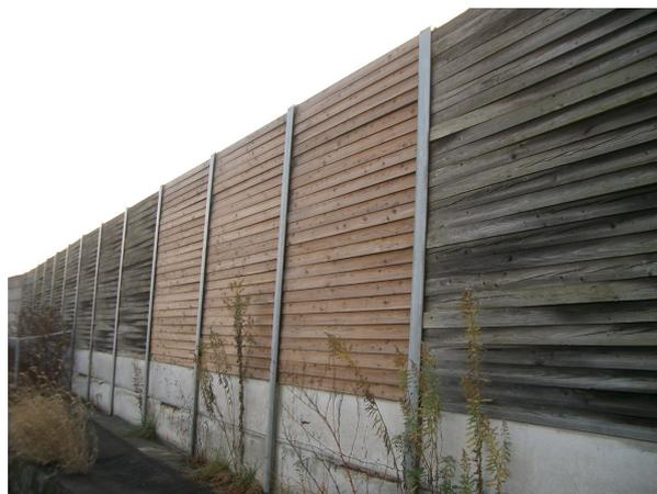
写真2 長野県に設置されているカラマツ製木製遮音壁 (20年経過後の部分と交換された部分(中央部分))
