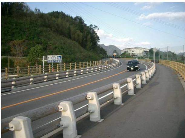
写真1 宮崎県に設置されているスギ製木製防護柵
