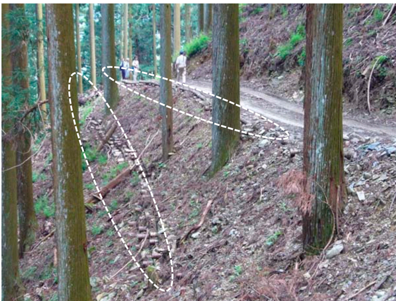
(同 急傾斜地での施工例 2)
