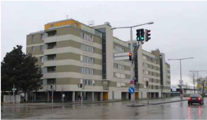
図1 ウィーン市内に建設された CLT を用いた 7 階建ての木造共同住宅
