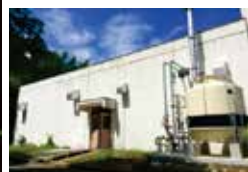
ベンチプラント外観
