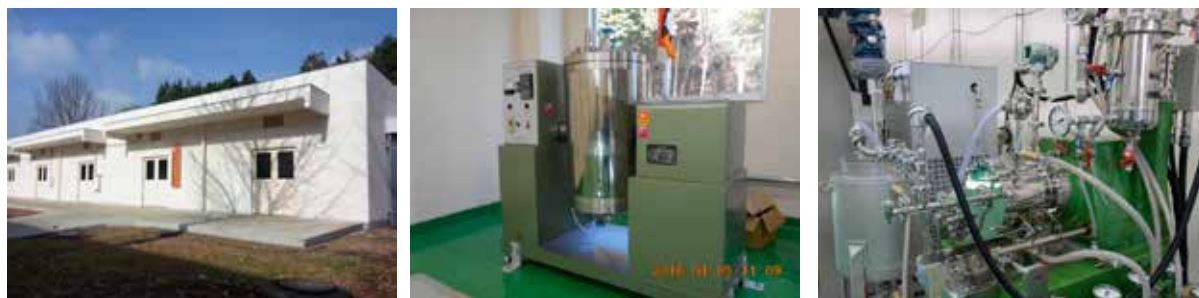
図2 セルロースナノファイバー製造技術実証事業で建設した実証プラント
