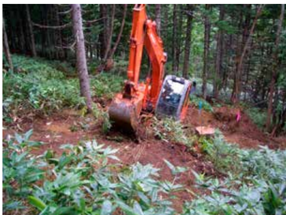
図1 小面積樹冠下地がき作業
