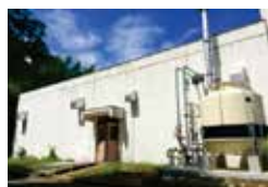
ベンチプラント外観
