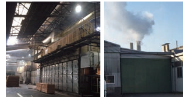
図1 合板製造時に排出する乾燥蒸気
