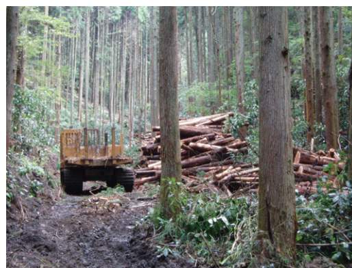
図4. 間伐実施中の作業道の様子
