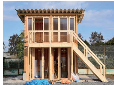
写真3 精度管理が容易なCLTパネル施工方法の開発 (逆差しアンカー工法(左)とそれを用いたCLTパネル工法による 試験建物(森林総合研究所構内)(右))
