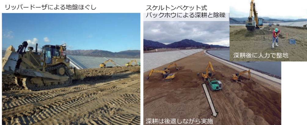
図3 「締め固めない盛土工」の施工風景：岩手県陸前高田市（小野賢二（他）（2020）より引用）
