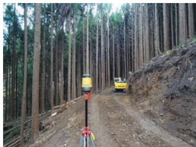
図1 トータルステーションによる油圧ショベル位置の計測
